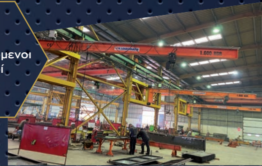
Περιστρεφόμενοι Γερανοί 3.5 / 3.2tn x 9m με ανυψωτικό εξοπλισμό Stahl. Εγκαταστάσεις Κ. Λιαρομάτης 2004, ΒΙ.ΠΕ. Πατρών
