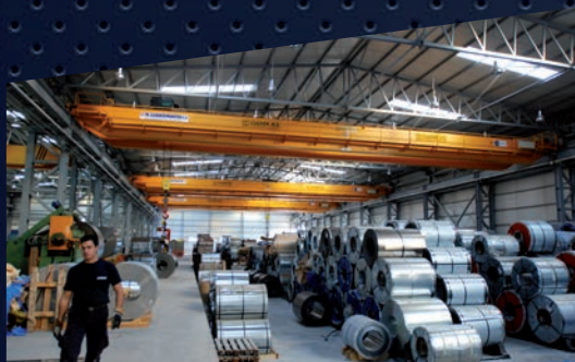
Επικαθήμενες Γερανογέφυρες Διπλού Φορέα 32, 25 & 20tn x 28.65m με ανυψωτικό εξοπλισμό Verlinde. Πελάτης: Sidma Steel 2007, Οινόφυτα Βοιωτίας
